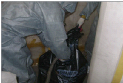
[그림 10-4] 석면폐기물 포장용기 이중 밀봉방법
