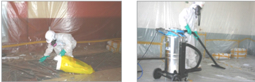
[그림 10-3] 석면함유 잔재물의 청소 모습
