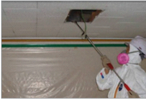
[그림 9-3] 코팅된 천장 텍스 뒷면의 습윤제 분무 예시
