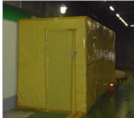
[그림 10-8] 석면폐기물 별도 보관장소 설치 예시
