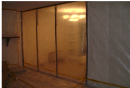
[그림 6-4] 임시벽 설치 사례
