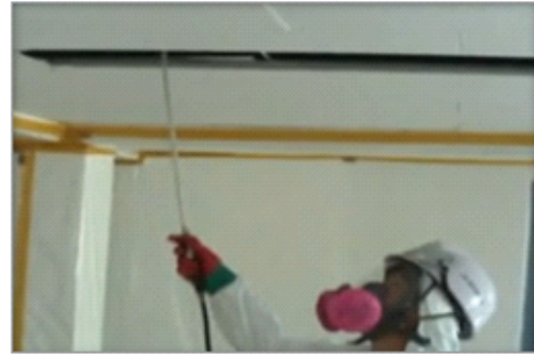
[그림 9-3] 코팅된 천장 텍스 뒷면의 습윤제 분무 예시
